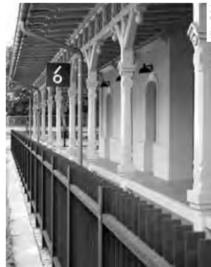
CORTENOVÝ PLECH ODDĚLUJÍCÍ KOLEJIŠTĚ OD DŘEVĚNÉ VERANDY
