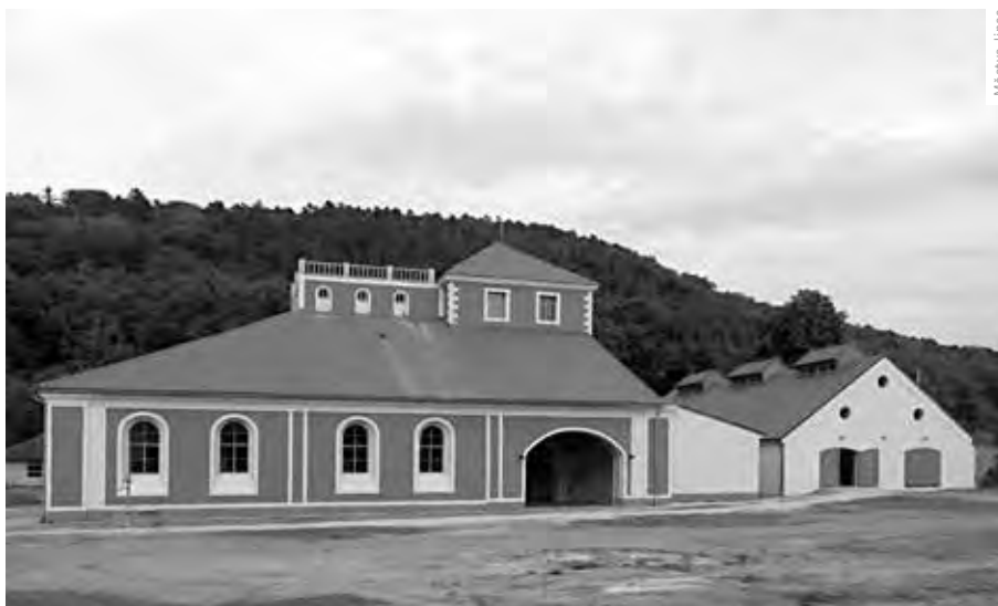
HUŤ SE SLÉVÁRNOU BARBORA V JINCÍCH NA PŘÍBRAMSKU BYLA PO OBNOVĚ OTEVŘENA VEŘEJNOSTI V KVĚTNU 2024.
