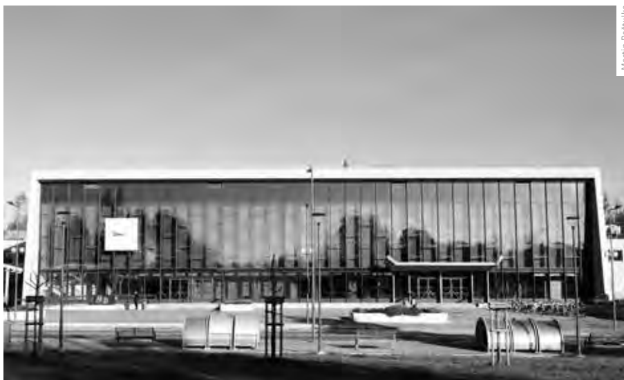
HLAVNÍ PROSKLENÉ PRŮČELÍ PO OBNOVĚ
