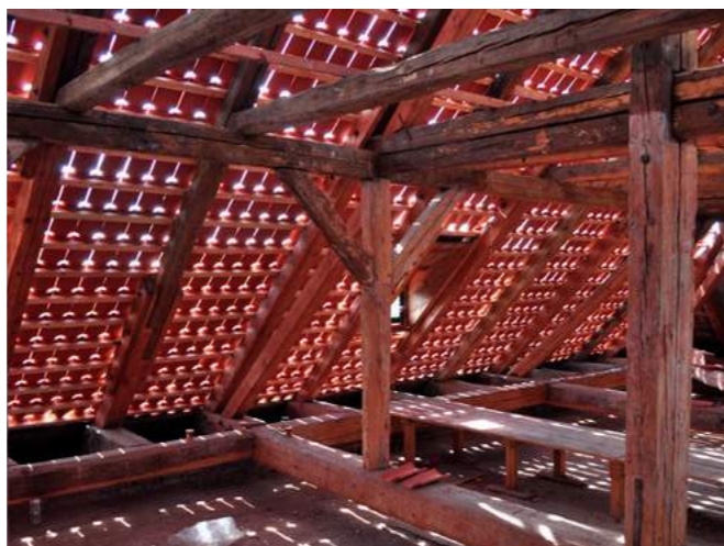
Zapoštění střechy – malý prež.
