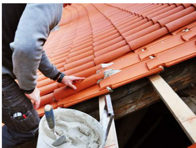
Pokládka kůrek – malý prejz.
