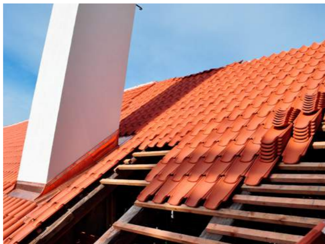
Zapoštění střechy – malý prež.
