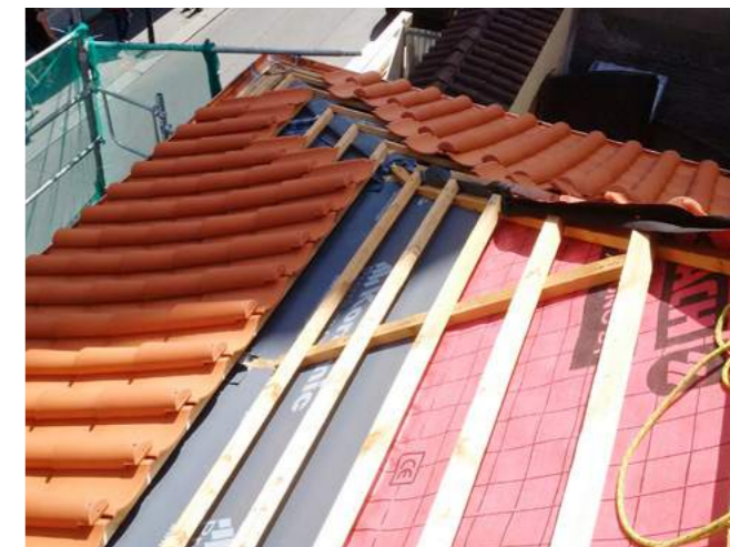
Velký prejz „pokládka na sucho“.
