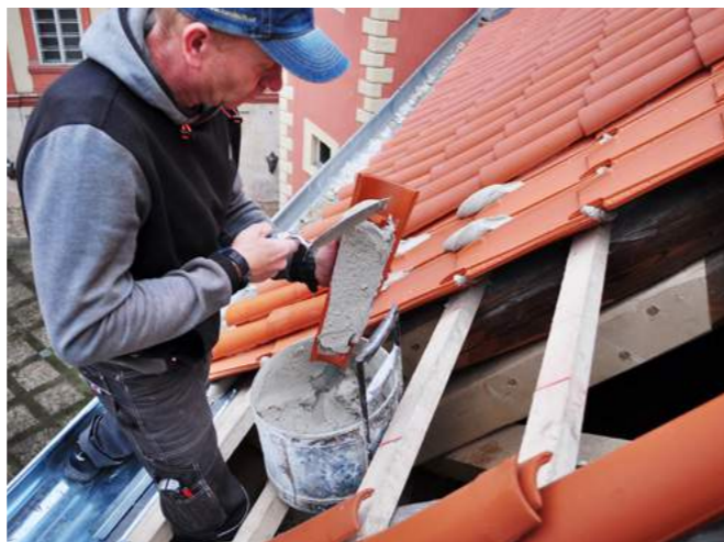
Pokládka kůrek – malý prejz.
