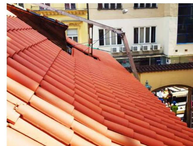
Velký prejz „pokládka na sucho“.
