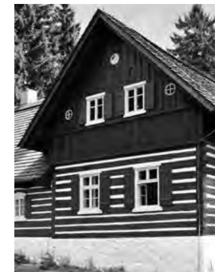
POHLED NA ŠTÍT S ODBORNĚ OŠETŘENOU ROUBENOU KONSTRUKCÍ
