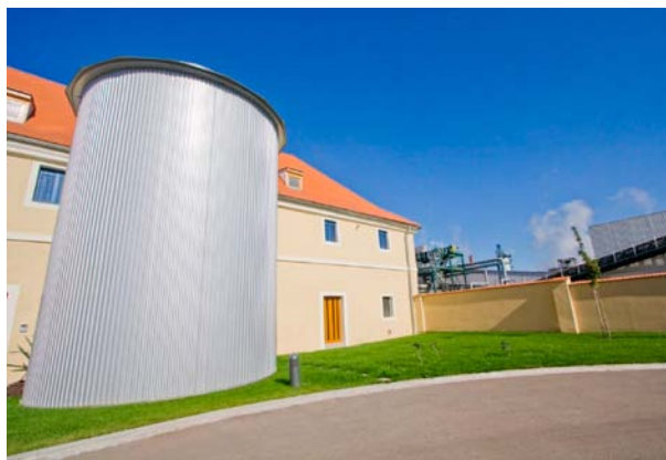
Obr. 3: Bezbariérový přístup – výtahová šachta – pohled z venku.
