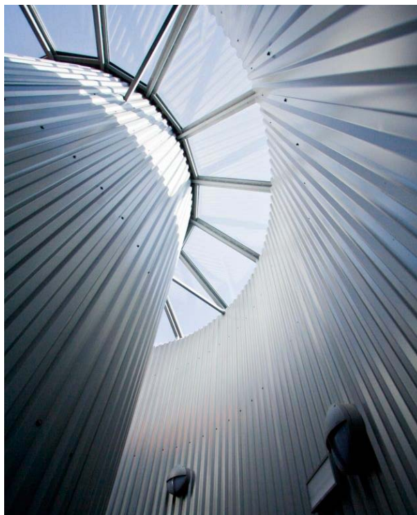
Obr. 4: Bezbariérový přístup – výtahová šachta – pohled zevnitř.
