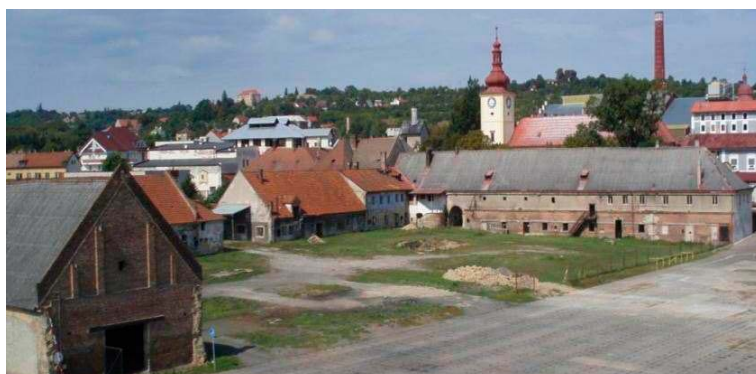
Obr. 2: Areál bývalého hospodářského dvora – před rekonstrukcí.
