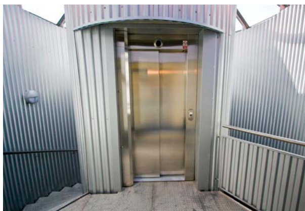
Obr. 5: Bezbariérový přístup – výtahová šachta – pohled zevnitř.
