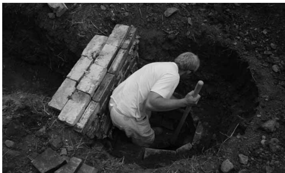
SDRUŽENÍ ZA OPAVU PŘI OPRAVĚ KAPLIČKY POUŽILO TRADIČNÍ ZPŮSOB PŘÍPRAVY VÁPNA.
