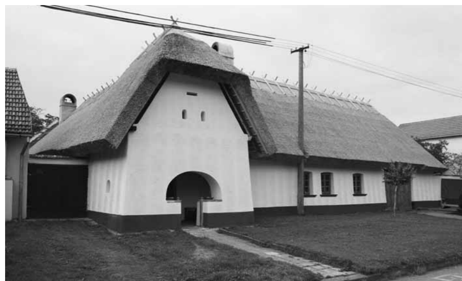
STAV DOMU PO CELKOVÉ REKONSTRUKCI.
