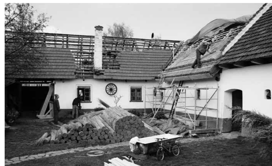
REKONSTRUKCE STŘECHY NAD OBYTNOU ČÁSTÍ V ROCE 2007.
