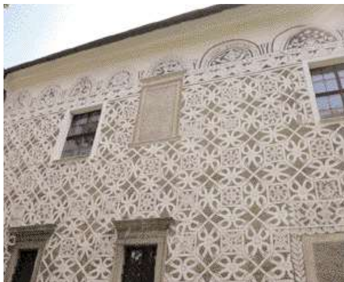
02 > Pohled na západní část fasády
