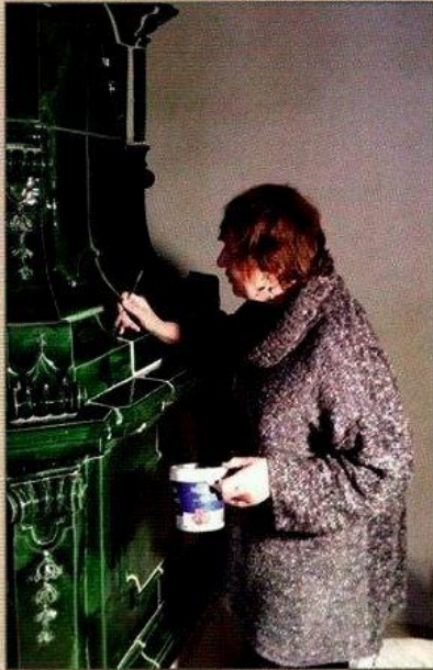
Paní mistrová, Jana Pešková, spáruje kamna a provádí závěrečné retuše (baroko)
