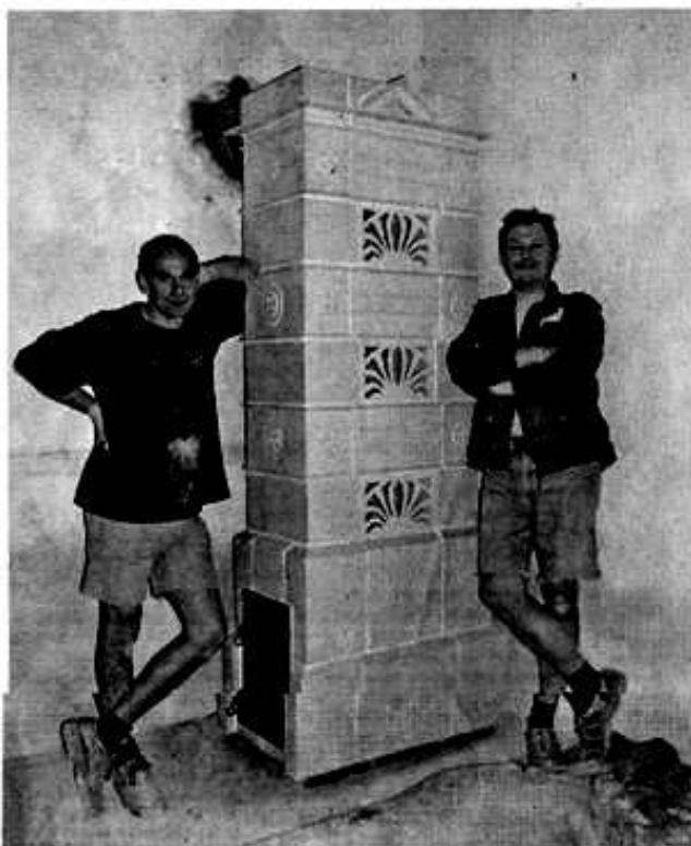
Z VLASTNORUČNĚ VYROBĚNÝCH KACHLŮ postavil Vít Pešek (vpravo) s kolegou Liborem Soukupem z Jindřichova Hradce repliku stěnové oheň bých biedermeierových kamen v rekonstruovaném klášteře v Českém Krumlově. Foto: archiv Vít Peška
