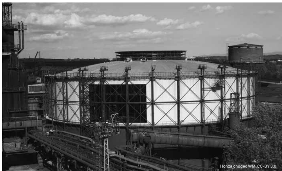
STAVBOU ROKU 2013 SE STALA OSTRAVSKÁ AULA GONG – KONVERZE PLYNOJEMU VÍTKOVICKÝCH ŽELEZÁREN.
